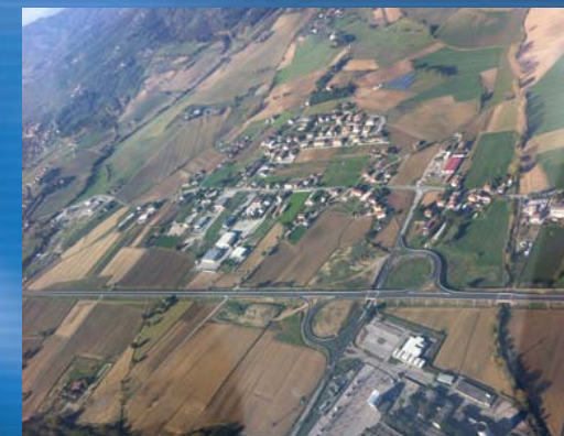
Svincolo di Pietrafitta, veduta aerea
